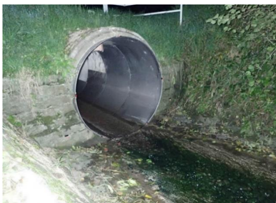
Joonis 7. Füüsilise tõrjemeetodi eesmärgil modifitseeritud truup (Chucholl et al. 2021).
